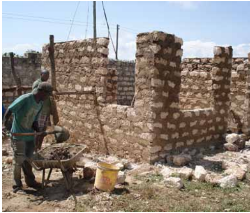
Oben: Die neue Küche mit Kochstelle ist bereits - neben dem Essensplatz - mitten im Bau.
